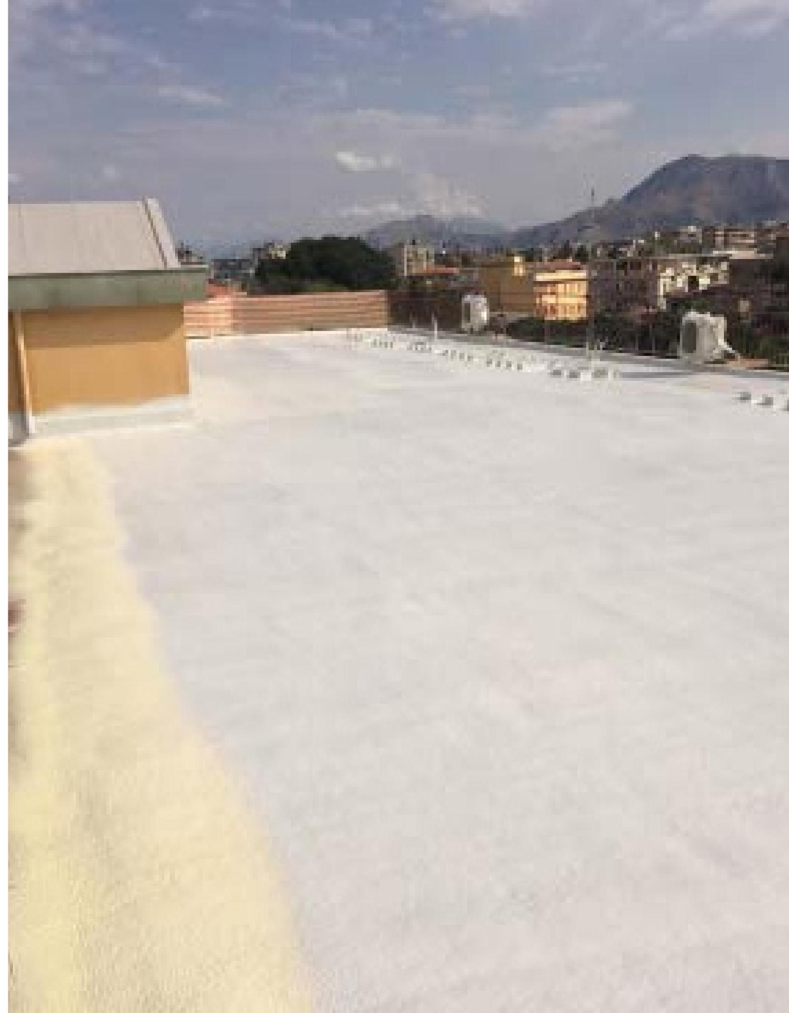
Il sistema è costituito da schiuma di Poliuretano espanso spruzzato in loco e rivestimento protettivo. i vantaggi sono:
